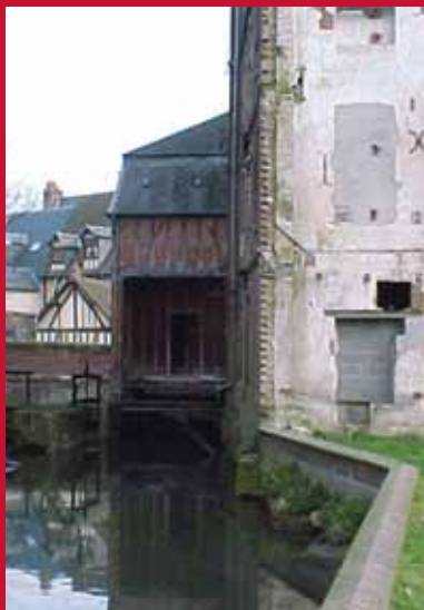
La minoterie et son bâtiment d'eau vus depuis le jardin. (cl. Service juridique, 1999)
